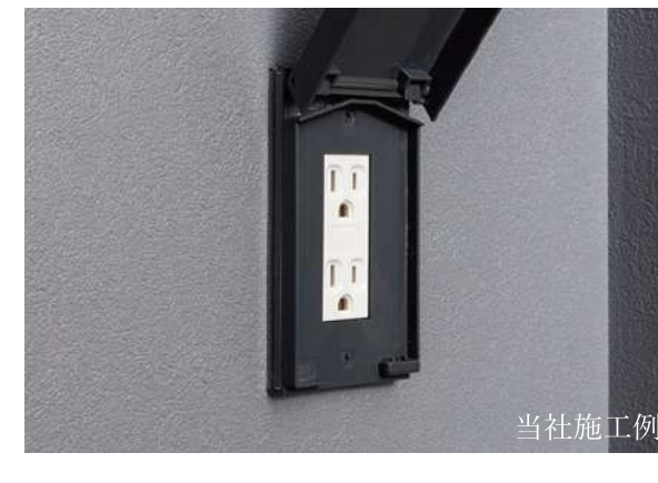
停電時携帯充電用コンセント
