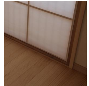
■断熱・気密を高める断熱障子
