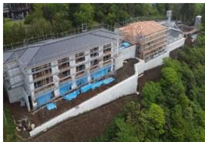
(ホテル四季の館 箱根芦ノ湖 工事中)
