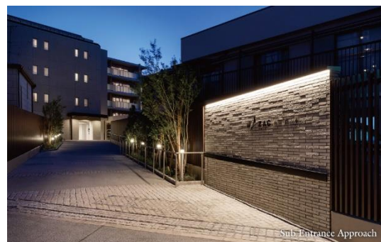
(ワザック大田・鶉の木 エントランスアプローチ)
